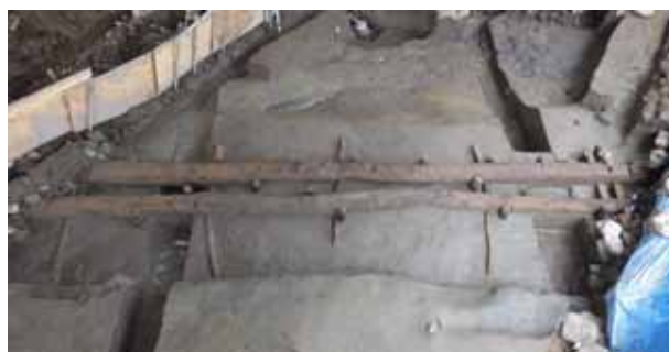
写真4 南側石垣の胴木検出状況（南から）
