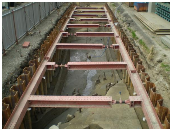
15-6 地区 外堀完掘状況
