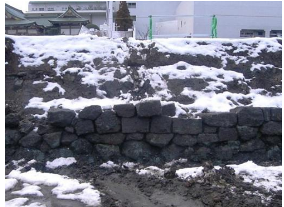
写真2 西側石垣（東から）
