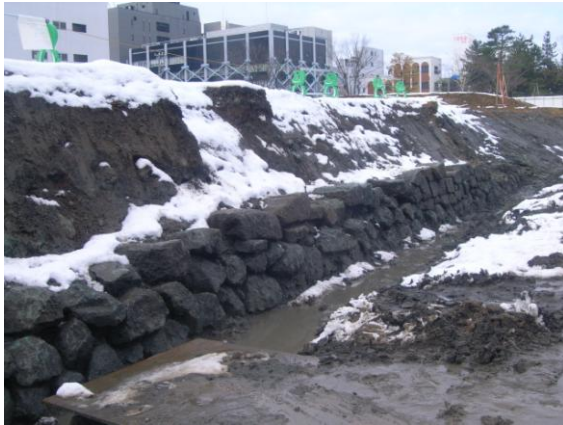
写真1 西側石垣（南東から）
