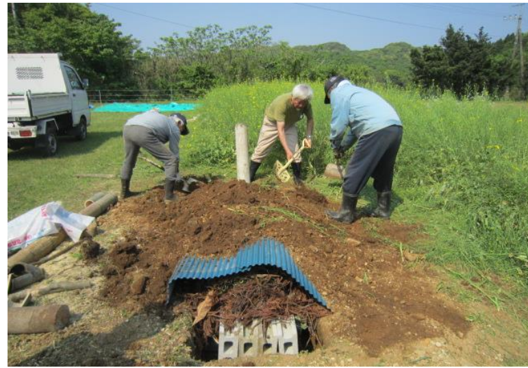
炭材を草や枝葉で被い、さらにその上をトタン、土で被って作る伏せ焼の炭化炉 (2)
