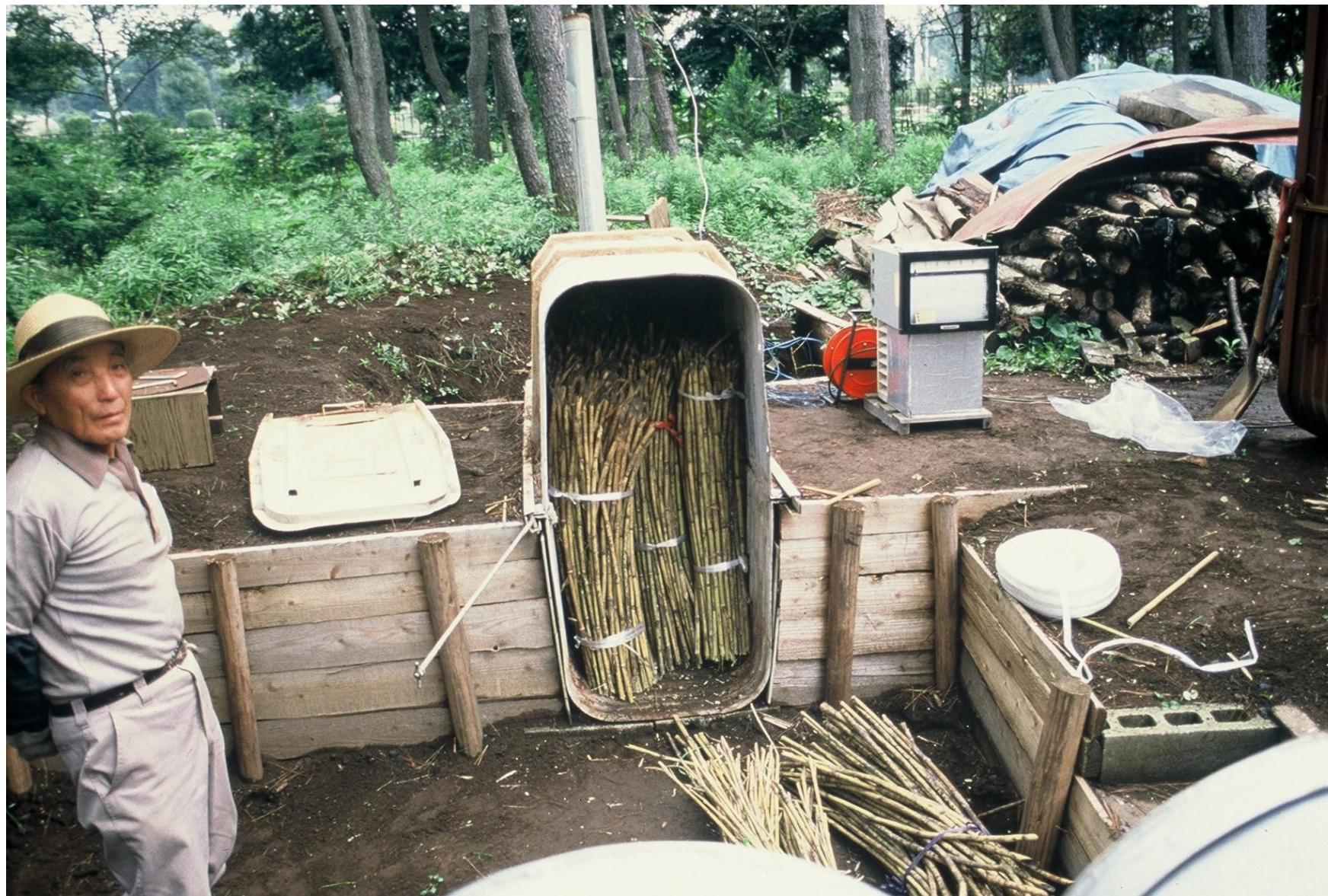
排水溝を利用した簡易炭化炉
