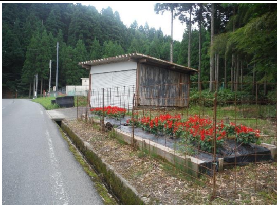
【トンネル付近】
