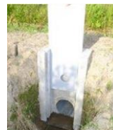
田んぼダム用「排水柵」 （小さな穴の調整版を取り付け、 水田からの水の流出を抑制）
