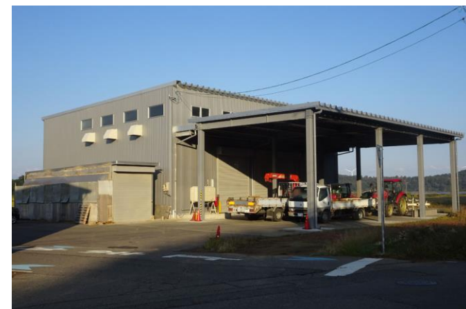
令和2年にライスセンター新設
