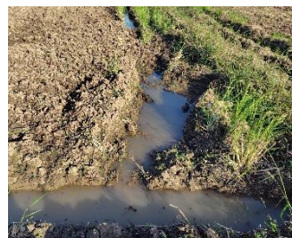
排水溝の崩れによる滞水
