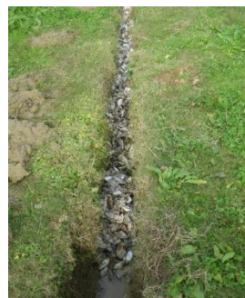
第 2 図 排水溝に充填した資材 （図はカキ殻）
