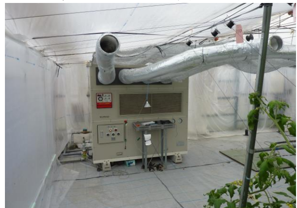
第1図 供試した地下水熱利用型ヒートポンプ
