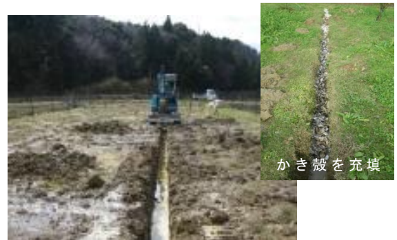
図2 排水溝設置の様子
