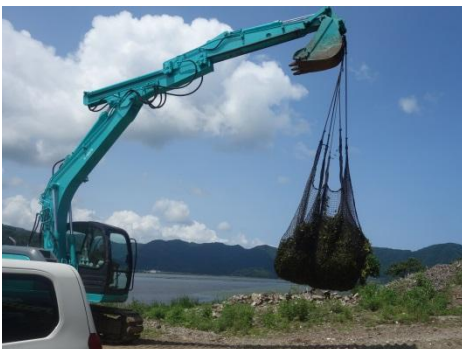
写真3 ヒシの陸揚げの様子
