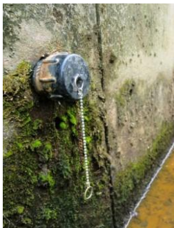
写真5 暗きょ排水口（閉めた状態）
