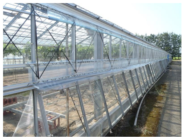
写真2 ビニール巻き上げ式に改良したガラスハウス
