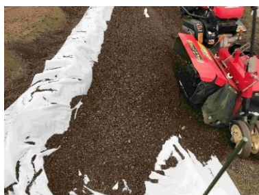
溝の横の土で埋め戻し
