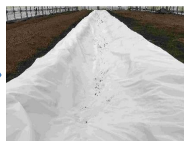
防根透水シートを敷設
