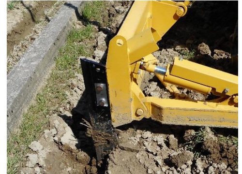
図7 明渠の底面に落としてから後進で補助暗渠に接続
