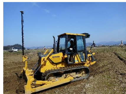
図3 ICTブルでの均平作業
