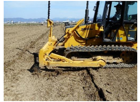
図6 補助暗渠を圃場縦横に施工
