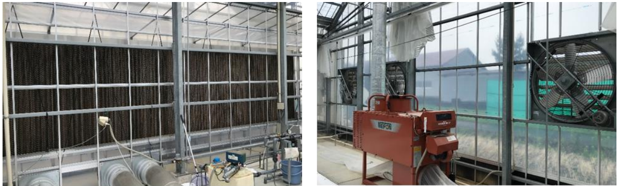
図3 パット&ファン 左：パット 右：換気扇
