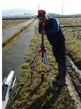
図2 地上基地局設置の様子
