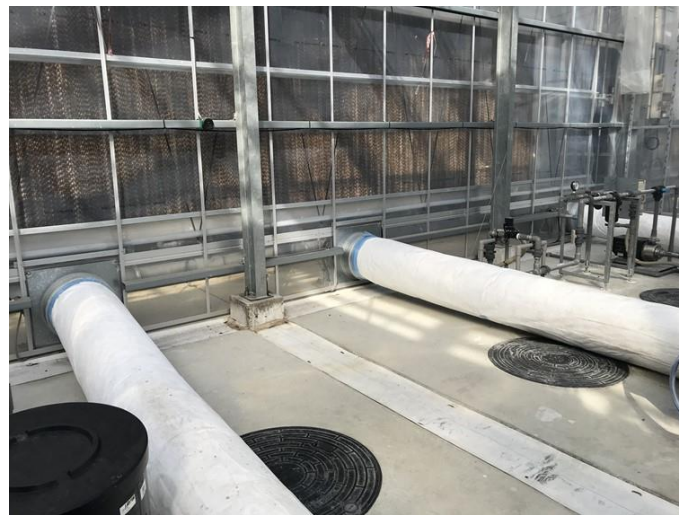
図 1.2 有圧ファンダクトによる送風
