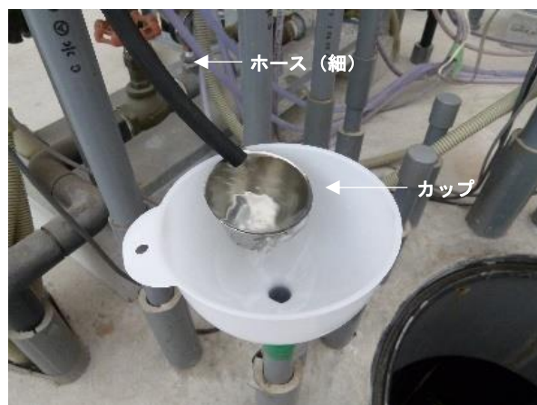
第10図 培養液採取部分
