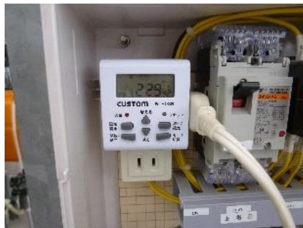
第8図 延長コード・ウィークリータイマー取付
