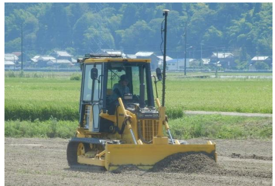
図1 ICTブルの作業風景
