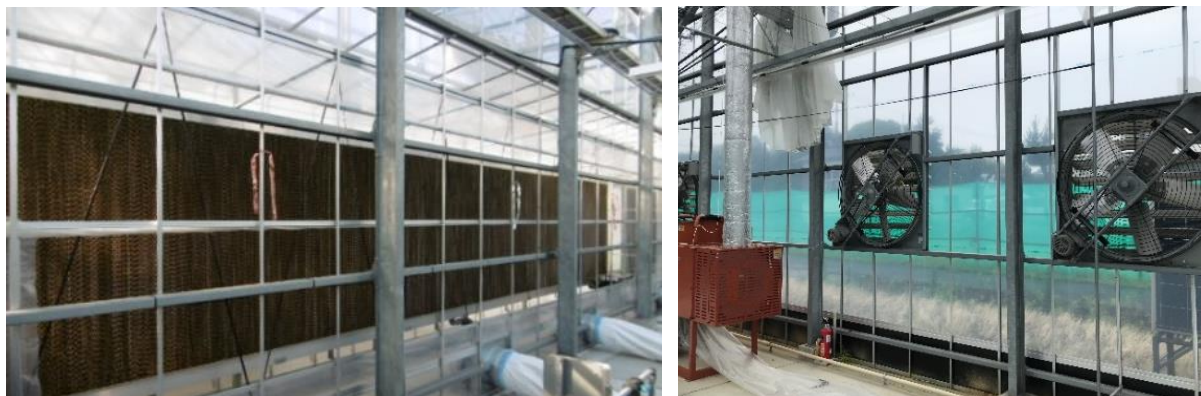
図 1.1 園芸研究センターに設置の有圧ファンダクト併用型パット&ファン
