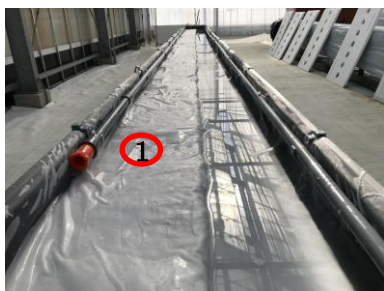
図8 ベッド内のノズル設置
