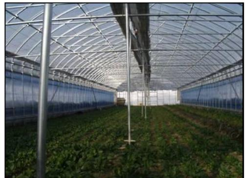
竹等をハウス内に持ちこみ準備しておき、降雪が予想される場合は、3～4 m間隔で支柱を立てハウスを補強する。また、積雪荷重により肩部が左右に広がると倒壊しやすくなるので、ワイヤー等で引き付けておく。ワイヤー間隔が約6 m以上になると、ワイヤー間中央部ではその効果がほとんどなくなるので、支柱と同等の間隔で、支柱の間に張ることが望ましい。
