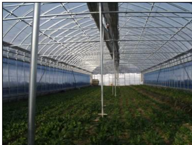
写真 4 ハウス内の支柱の設置
