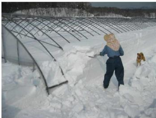
ハウスを覆うぐらいの積雪があった場合、肩部から除雪を始める
