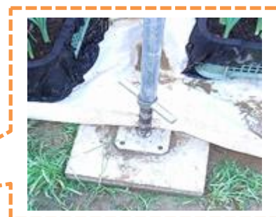
ジャッキ付き台で調整 ブロックや厚板で沈込み防止
