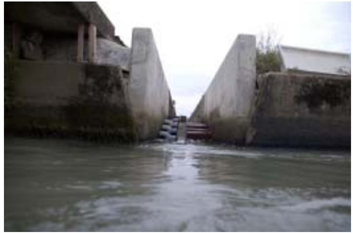
【魚道設置状況】
