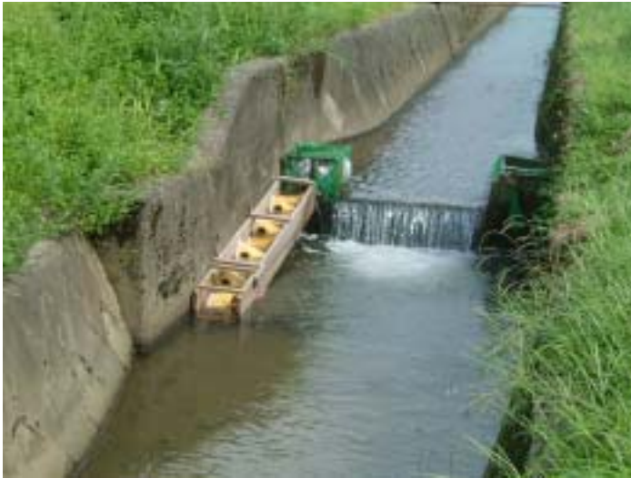
【魚道設置状況】
