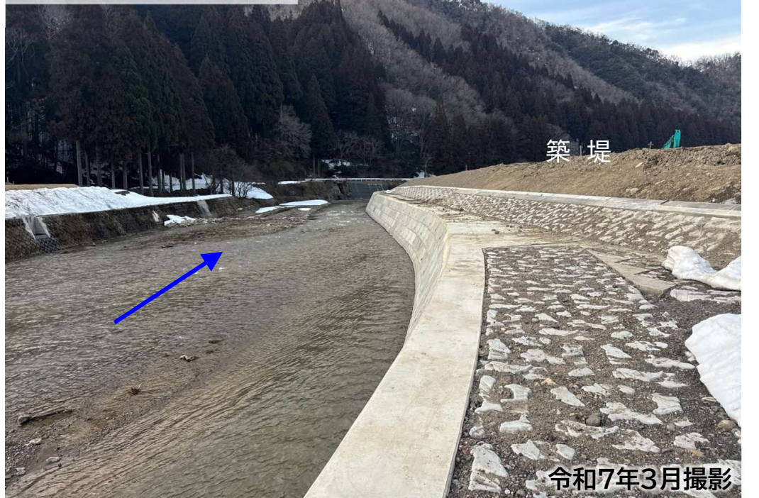
築堤区間【完成】
