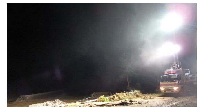
照明車の稼働状況 (南越前町)
