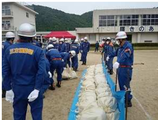
②改良積土のう工法Ⅰ型
