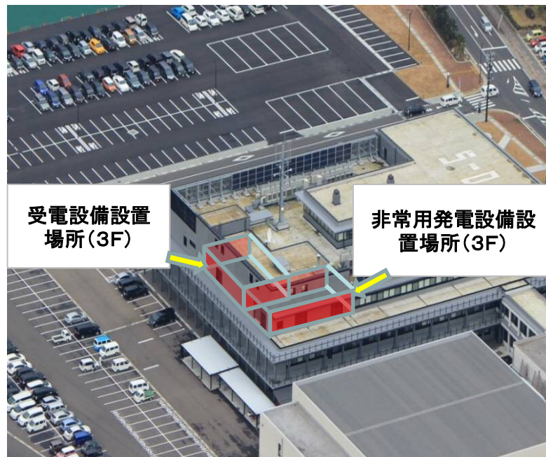
庁舎建替えに合わせ、受電設備、非常用発電設備を3Fに設置(大野市)
