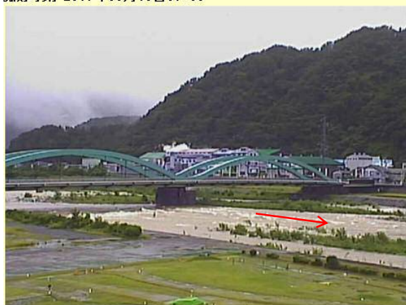
河川監視カメラ画像(九頭竜川 勝山市比島)
