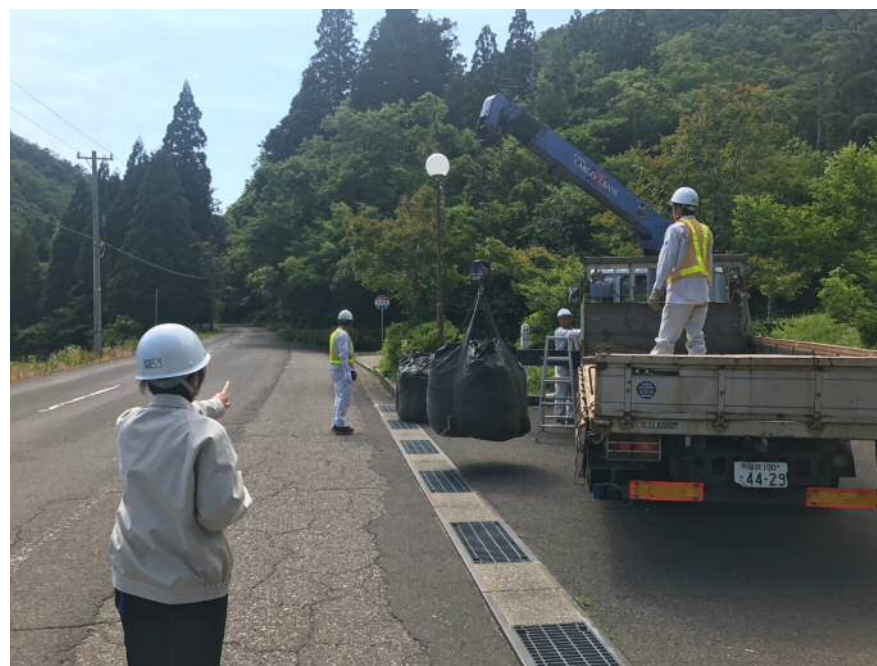
ロールプレイング水防演習現場対応(丹南土木)
