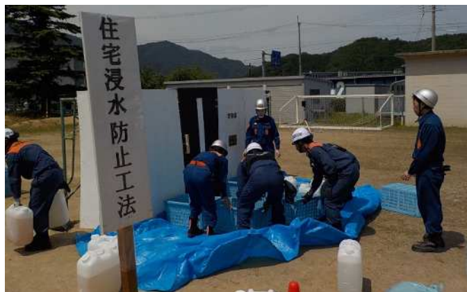
⑥住宅浸水防止工法
