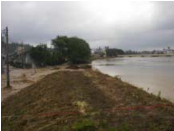
足羽川左岸破堤：木田橋上流付近
