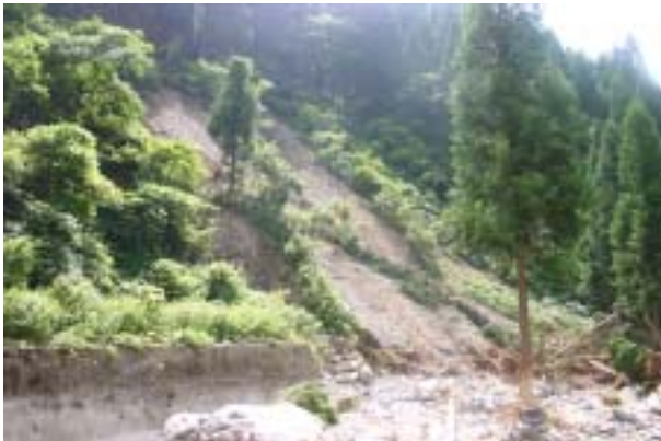
切土法面の崩壊状況 （池田町 千代谷～小畑線）
