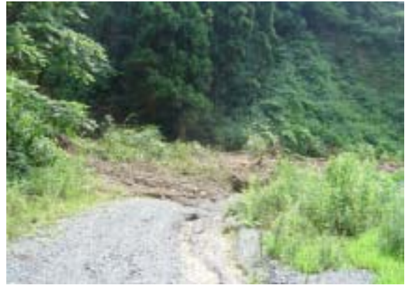
谷部からの土砂流入状況 （美山町 美山線）
