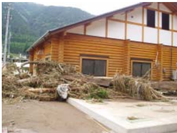
集落排水処理施設の河川溢水被害 (美山町下味見)
