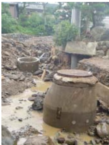
集水施設の損壊 (美山町三万谷)
