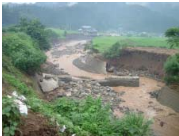
頭首工の損壊(福井市東新町)
