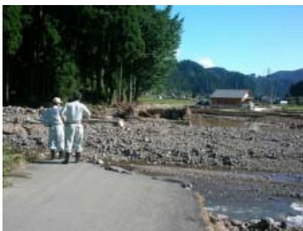
道路の流失(美山町東天田)
