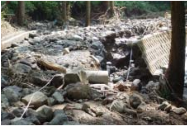
暗渠埋塞による被害状況（福井市） （福井市 赤岩線）
