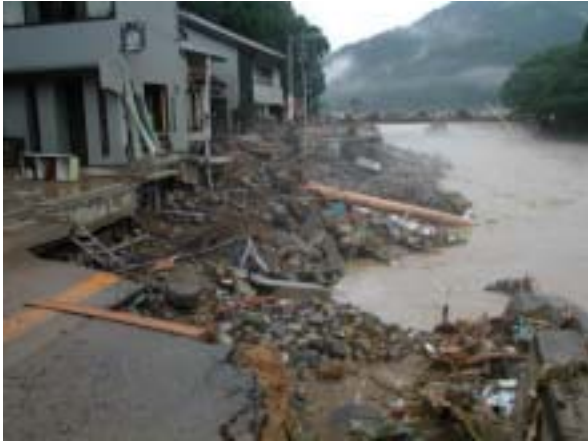
国道476号線路体流出状況(美山町西河原)
