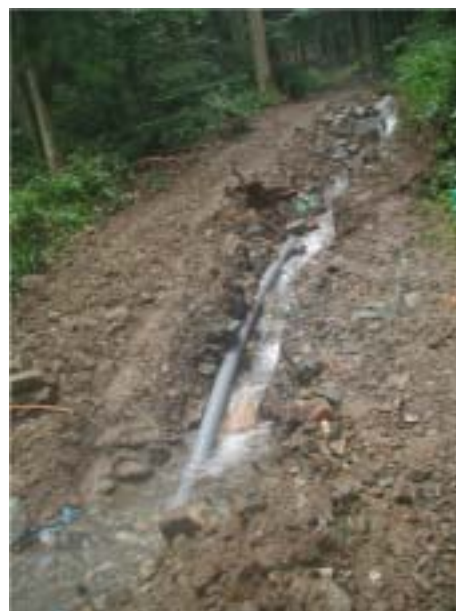
営農飲雑用水施設の管路破損 (美山町西天田)
