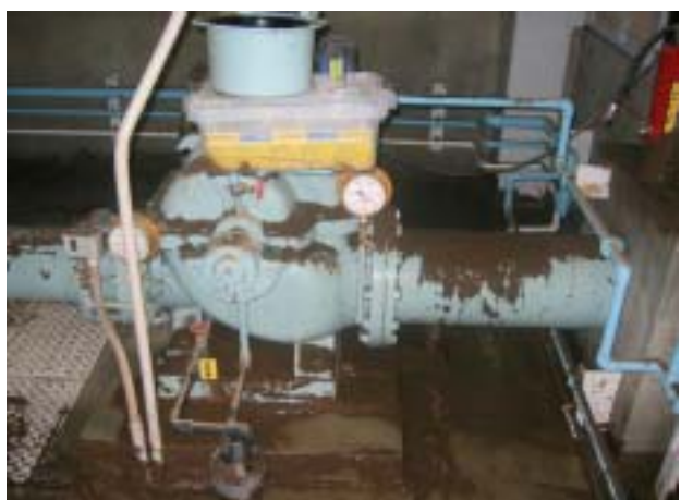
揚水機場内への土砂流入(今立町)
