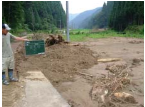
溪流からの土砂・雑物の流入堆積 （池田町千代谷）
