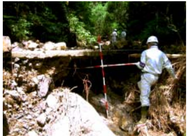
林道路体の洗掘状況 (池田町 奥の谷線)
