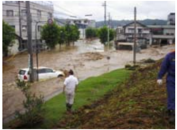
浸水状況：破堤付近
