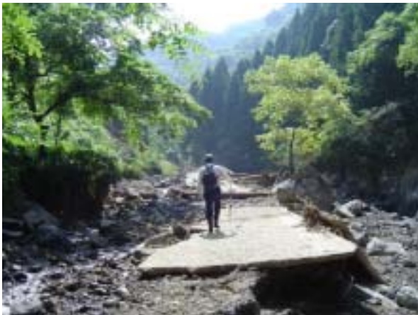
林道路体の流出状況 (福井市 藤懸線)
