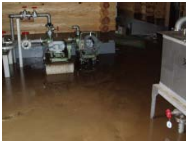
処理場内への浸水 (美山町下味見)
