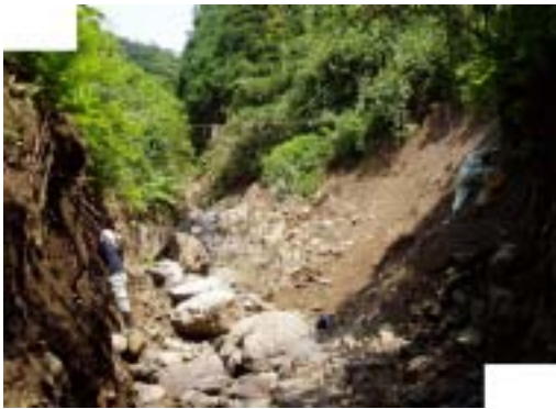
溪岸侵食状況（浄教寺地区、横断 No.1）
