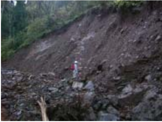
崩壊地状況（浄教寺地区、地点 1）
