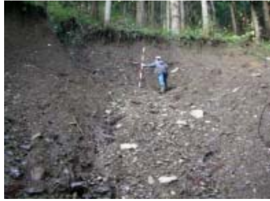
崩壊地状況（下池田地区、地点 2）
