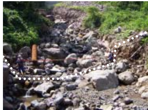
溪岸侵食状況（蔵作地区、横断 No.5）
