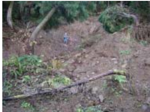
崩壊地状況（蔵作地区、地点 2）
