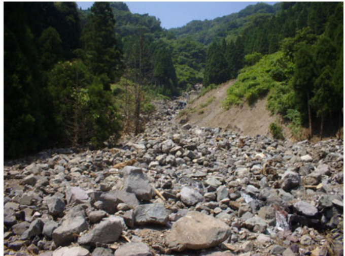
写真-5 砂防堰堤上流の堆砂状況
