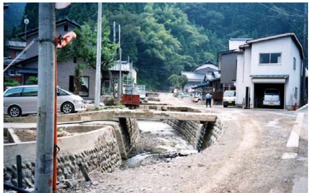
写真-3 土石流堆積物撤去後状況（美山町蔵作）
