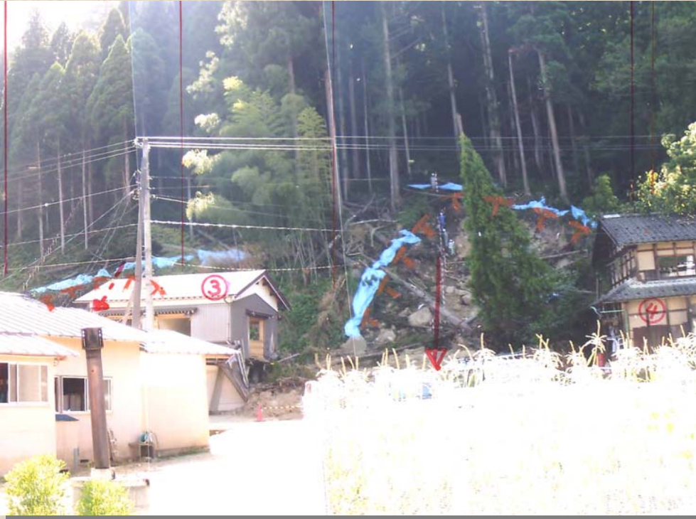
被災状況写真
