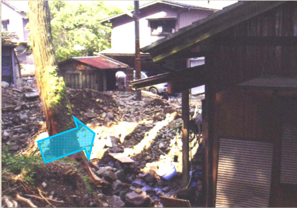
被災状況写真
