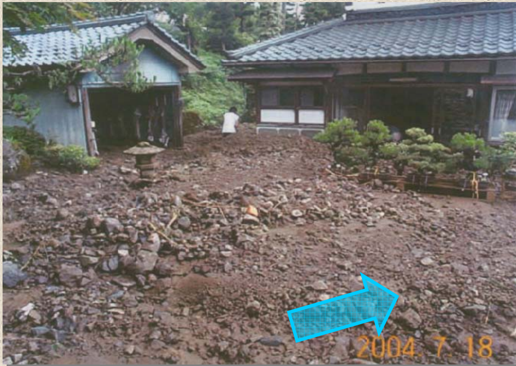
被災状況写真
