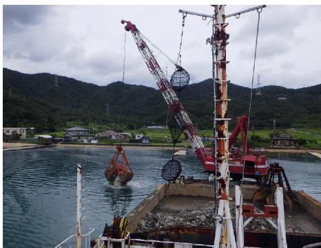
4号離岸堤施工状況（令和6年）
