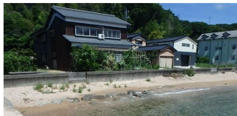
2号離岸堤（昭和61年完成）
