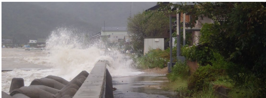
敦賀港海岸（常宮地区縄間）
