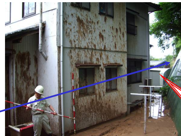
崩壊土砂の捕捉により、人家被害を回避
