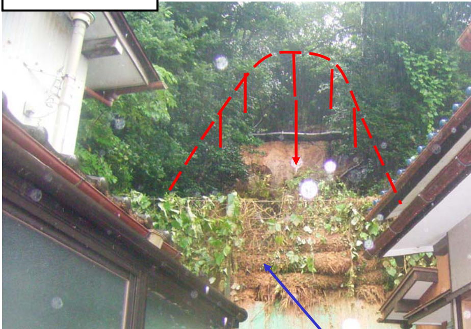
被災全景写真
