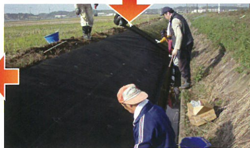
★ 防草シート張り
