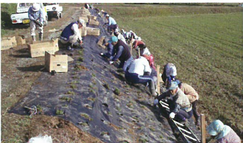
★ 農道法面への植栽
