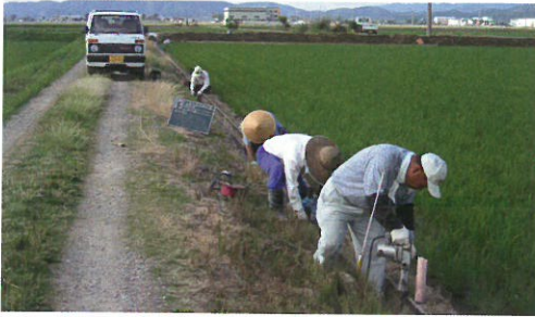
★ 用水路の目地補修作業
