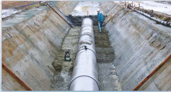
県営かんがい排水事業 東江地区
