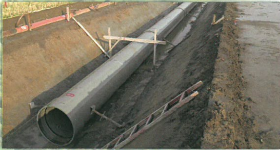
県営かんがい排水事業 五ヶ江地区
