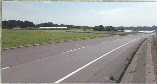
県営農道保全対策事業 坂井北部2期地区
