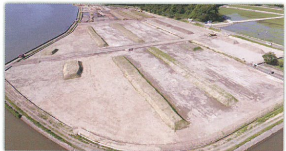
県営経営体育成基盤整備事業 細呂木地区
