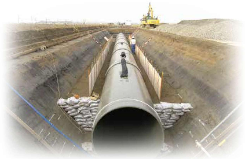
農業用水路のパイプライン化
