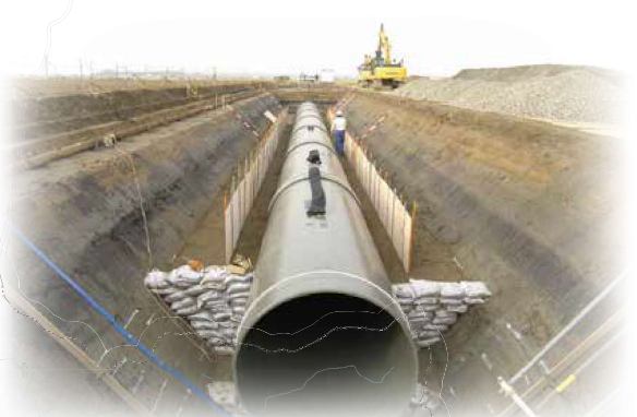
農業用水路のパイプライン化
