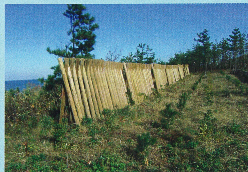
丸太防風柵工（冬期風浪等から植栽木を守るため、県産間伐材を活用した防風工を施工しています。）
