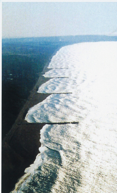
突堤工状況 (あわら市波松より坂井市三国町浜地方面を望む)
