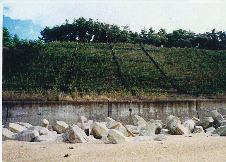
森林造成状況(海側より山腹面を望む)
