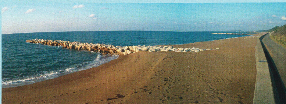
突堤工（漂砂活動を抑制し、汀線の安定を図っています。）
