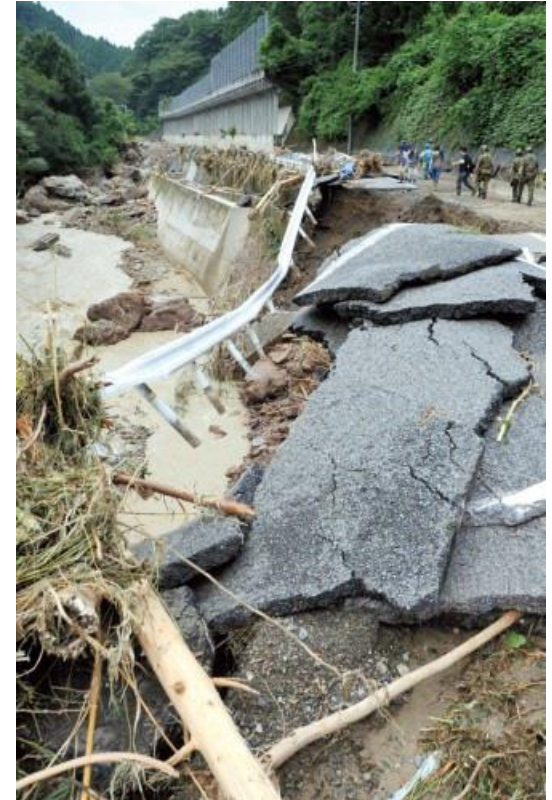
路面が崩れた津和野町内の県道萩津和野線
