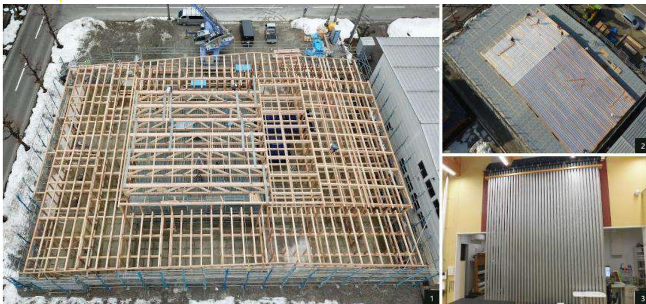
1. 県産材を利用した中大規模木造建築 2. 遮断熱工法による建築で、冷暖房にかかるエネルギー消費量を削減 3. 地下水を利用したエコな水冷空調システム
